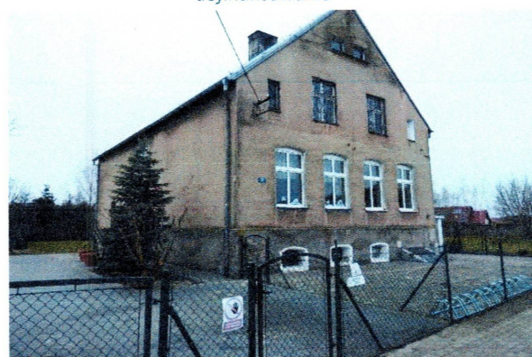
Zdjęcie 13 Budynek Społecznej Szkoły Podstawowej w Zalesiu
